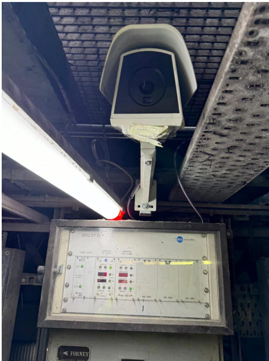
Ein neuartiges thermisches Überwachungssystem in einem wichtigen irischen Kraftwerk ermöglicht die Branderkennung in Echtzeit, eine kontinuierliche Zustandsüberwachung und eine KI-fähige Infrastruktur.
