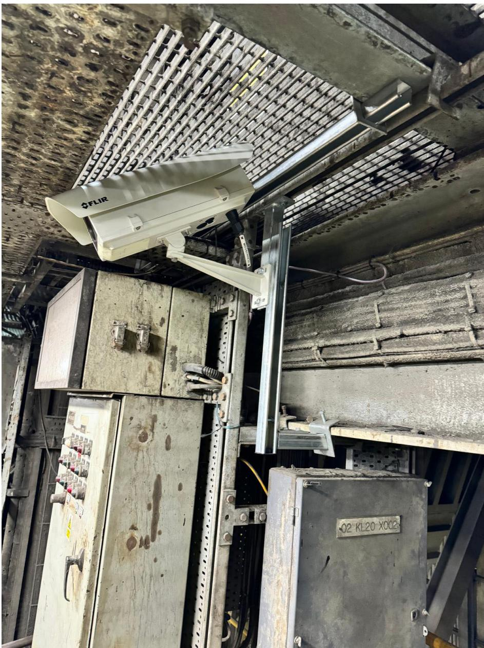
Im irischen Kraftwerk Moneypoint kommen die Wärmebildkameras »FLIR A500f« und »A70« zum Einsatz, um das Stromnetz vor kaskadenartigen Ausfällen zu schützen.
