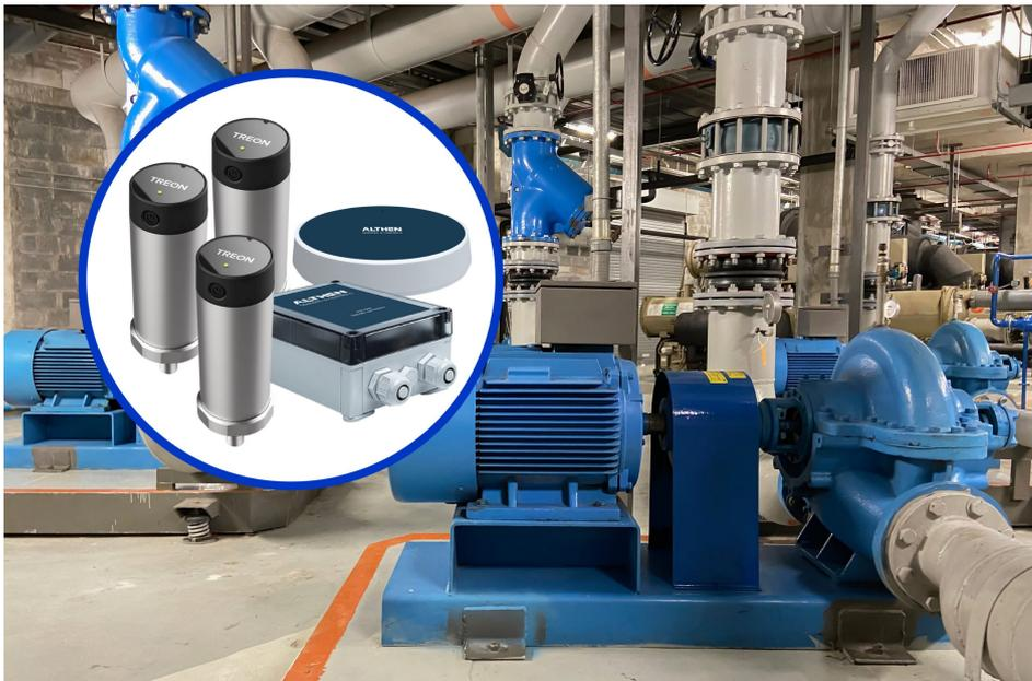
Mit der funkbasierenden Zustandsüberwachung von Althen können vibrationsbedingter Verschleiß an rotierenden Anlagenteilen rechtzeitig erkannt werden. Geplante Wartungsarbeiten lassen sich dann gezielt durchführen. Bild: WIROT, Adobe-Stock/Althen
