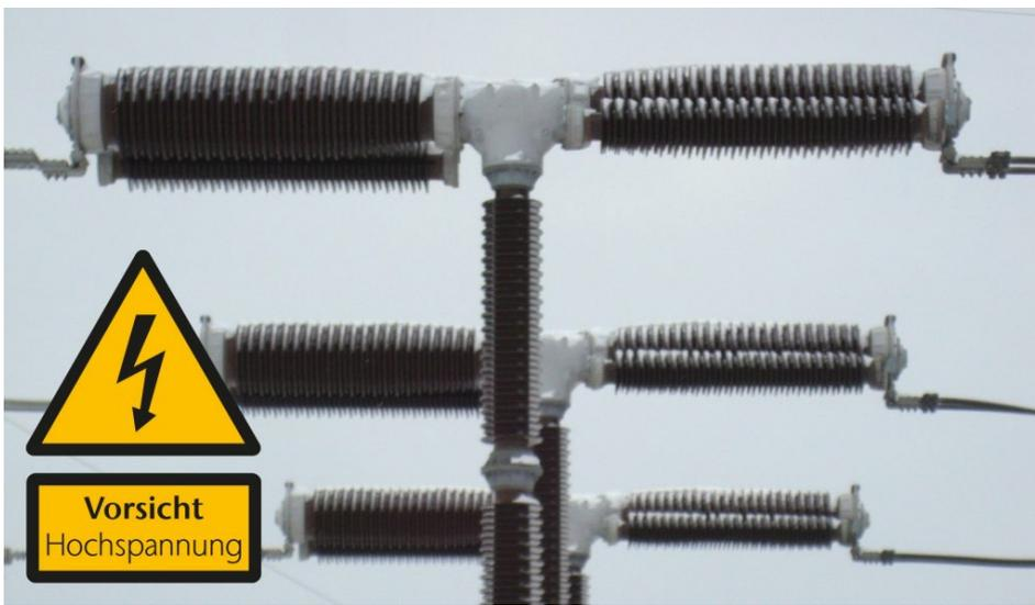
Lose Verbindungen an Isolatoren lassen sich lokalisieren, ohne dass der Mensch den Gefahrenbereich betreten muss.
